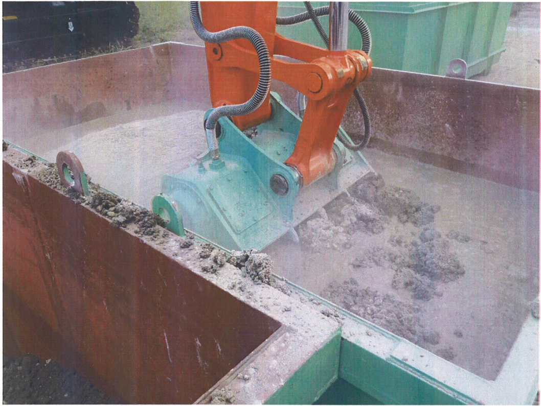
ドライブミキシングによる攪拌
