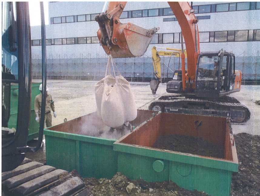
土壌改良材投入
