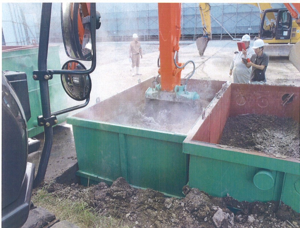
ドライブミキシングによる攪拌
